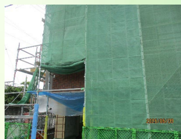
外壁工事中のA棟
